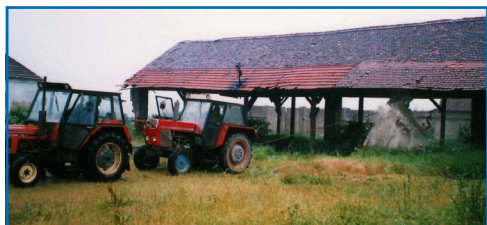
Dva traktory táhnou, jeden nestačil na zbourání budovy.
